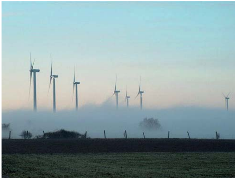
Photo : © Centrales éoliennes de la Haute-Lys - Régis Lombart
