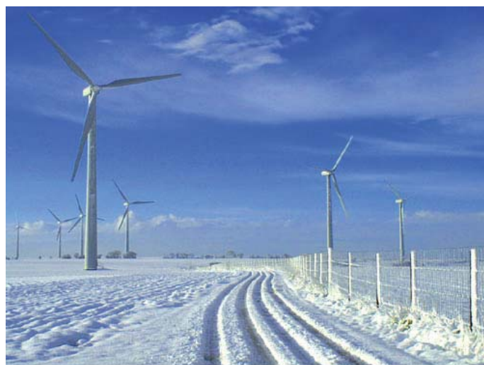
© Centrales éoliennes de la Haute-Lys - Photo : Régis Lombart
