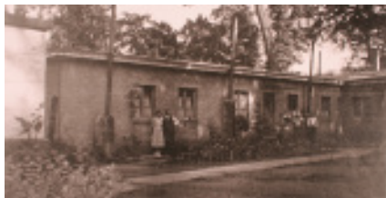
Bâtiments des dessinateurs transformés en habitation après la Seconde Guerre mondiale.
