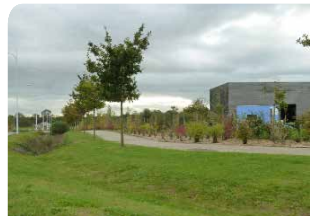
Porte Multimodale de l'Aa - 2013
