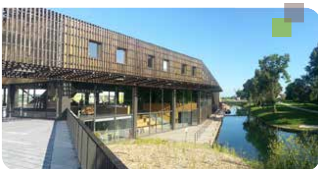
Maison du Marais en travaux - Juillet 2014
