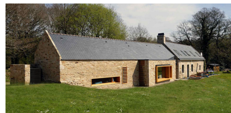
Hors territoire : extension et réhabilitation Projet : © Grignou Stéphan Architectes / Photo : ©Dieter Kik
