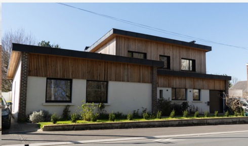
Avant-après surélévation à Saint-Martin-lez-Tatinghem
