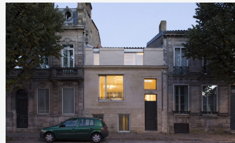
Hors territoire : surélévation Projet : © Marien Architecte / Photo : © Sandrine Iratgabal
