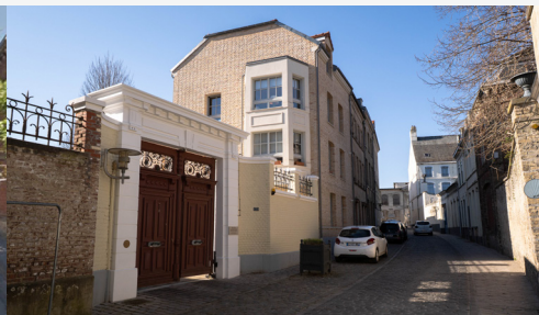
Avant-après démolition-reconstruction à Saint-Omer
