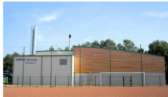
ILLUSTRATION 52. CHAUFFÈRE BIOMASSE ALIMENTANT LE RÉSEAU DE CHALEUR À ARQUES
