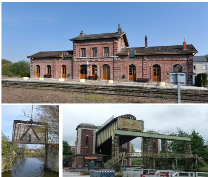
ILLUSTRATION 47. EXEMPLES DE PATRIMOINE DU GÉNIE CIVIL
