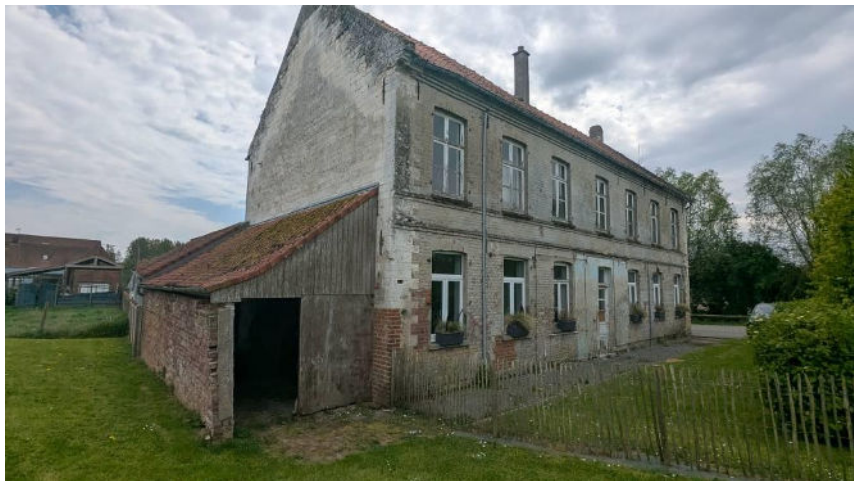
Façade arrière du bâtiment
