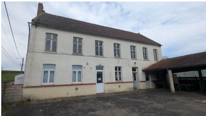
Façade sur cour
